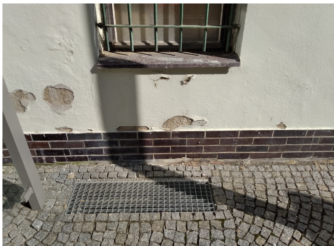
Obrázek č. 4, 5 – pohled z přednádražního prostoru na hlavní část VB Obálka budovy je v relativně dobrém technickém stavu, nicméně jsou patrné poruchy vnější omítky
