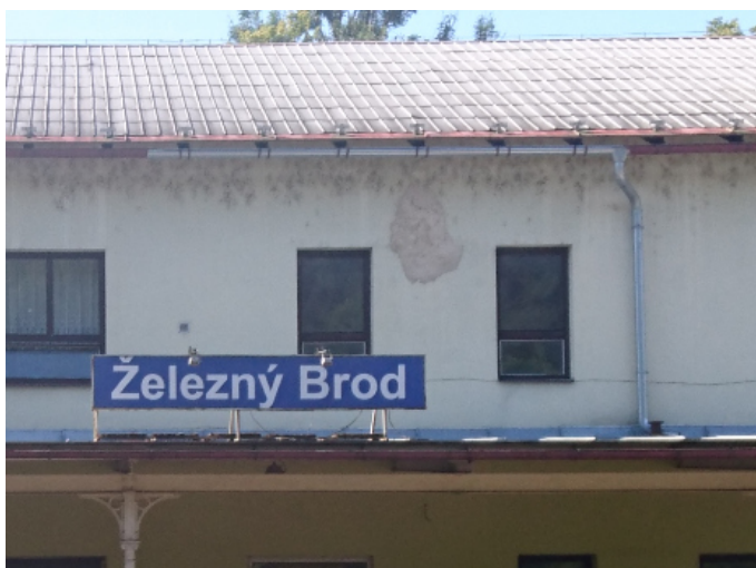
Obrázek č. 3 – pohled z přednádražního prostoru na hlavní část VB Obálka budovy je v relativně dobrém technickém stavu
